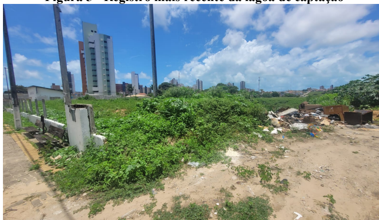
Figura 5 - Registro mais recente da lagoa de captação
